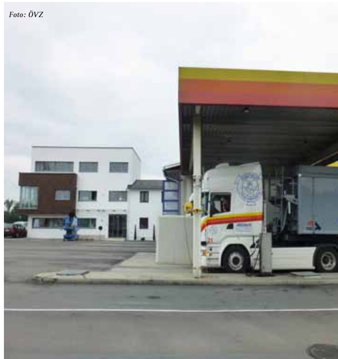
Mit dem neuen Bürogebäude wurde mehr Platz geschaffen.
